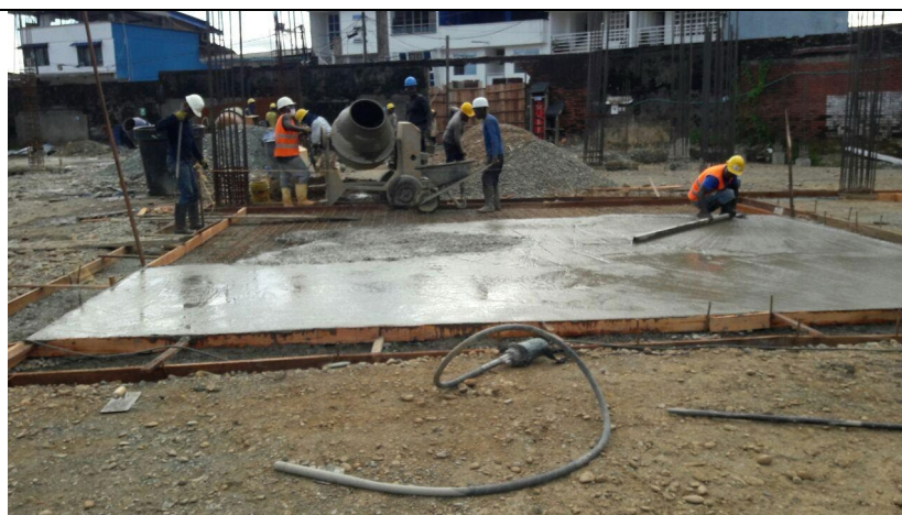
Fundición de placa de contrapiso bloque de aulas
